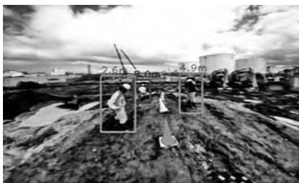
写真—3 人の検知と距離の推定
