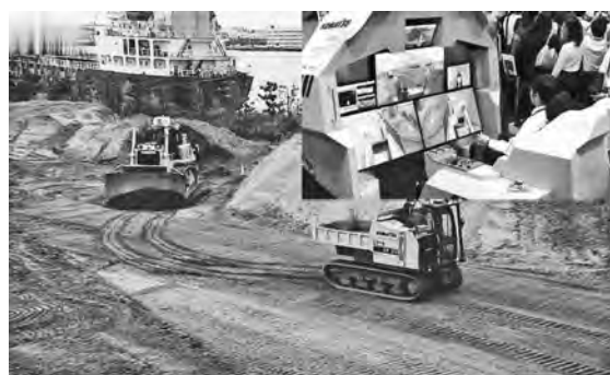
写真—2 遠隔操縦ブルによる敷き均し
