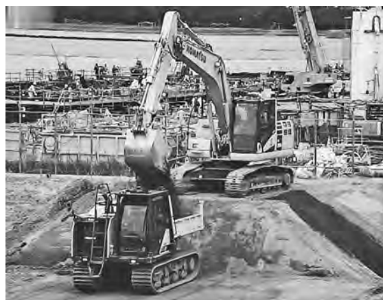
写真—1 自律建機による掘削・積込
