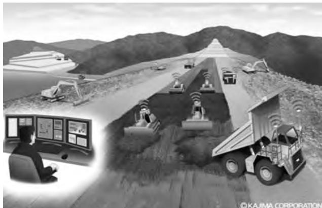
図一 本システムのダム堤体施工イメージ
