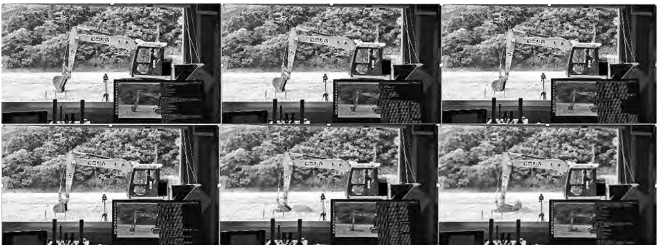
写真—4 教師あり学習で学習した方策を用いて掘削した様子
