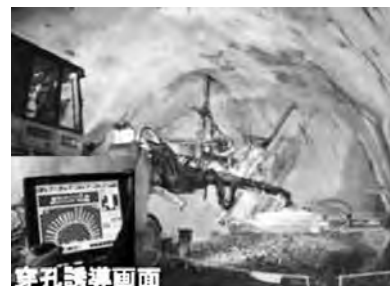
ロックボルト穿孔状況
