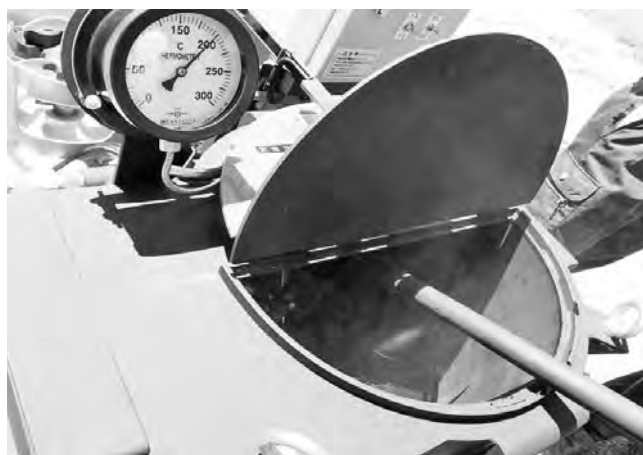
材料（シール材）熔解状況
