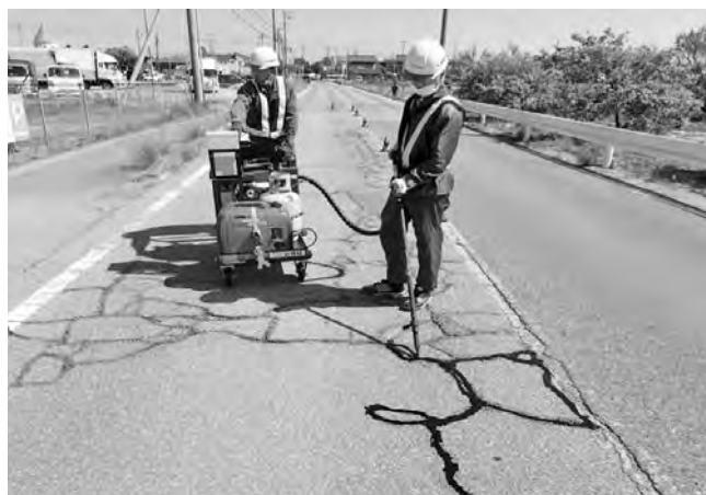
舗装クラック注入状況
