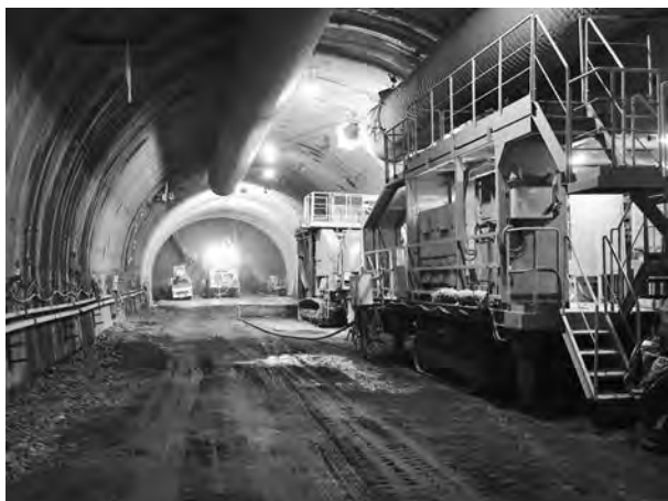
写真—3 坑内作業状況
