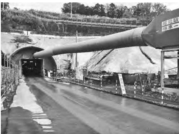
写真—1 上り線坑口
