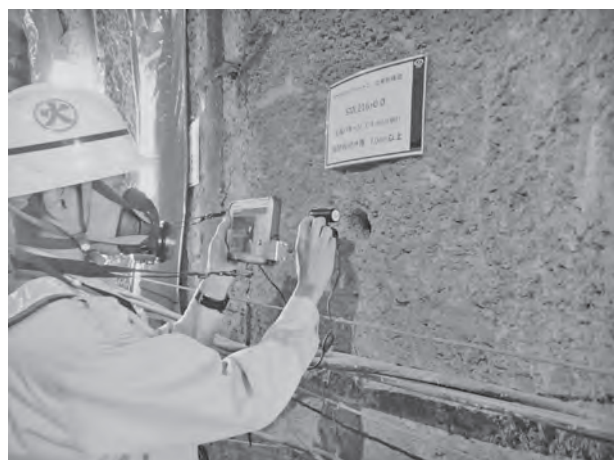
図－2 遠隔立会状況（吹付けコンクリート厚さ検測）
