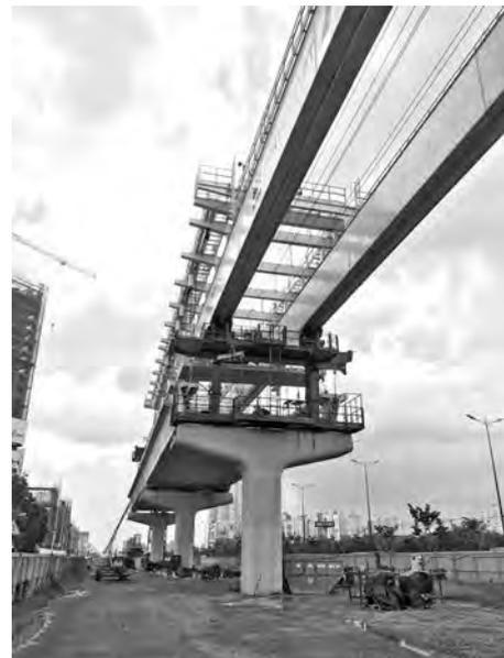
写真—3 エレクションガーダーによる桁架設状況 (出典：NJPT 撮影)
