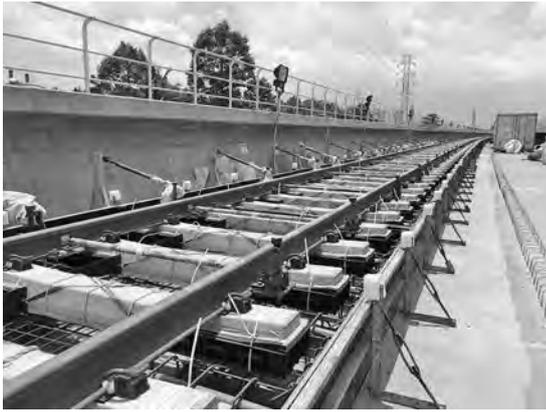
写真—5 防振装置付き PC マクラギ軌道 (出典：NJPT 撮影)
