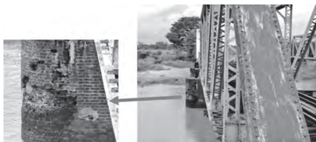
写真一3 トラス橋とブリックでできた橋脚
