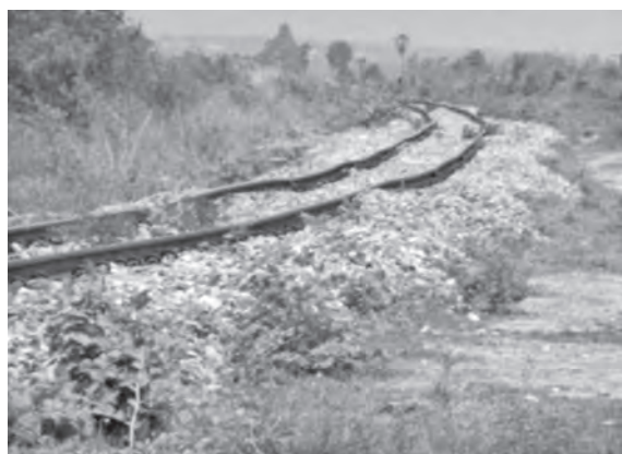
写真一2 軌道狂いの状態
