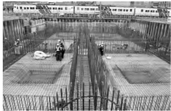
写真-1 大屋根基礎部施工状況
