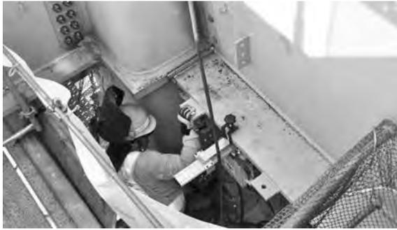
写真一5 ロボット溶接施工状況
