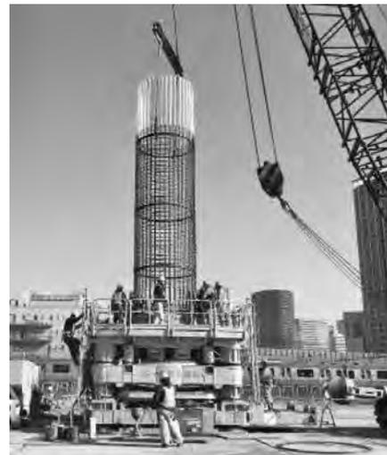
写真－4 鉄筋かご建込施工状況
