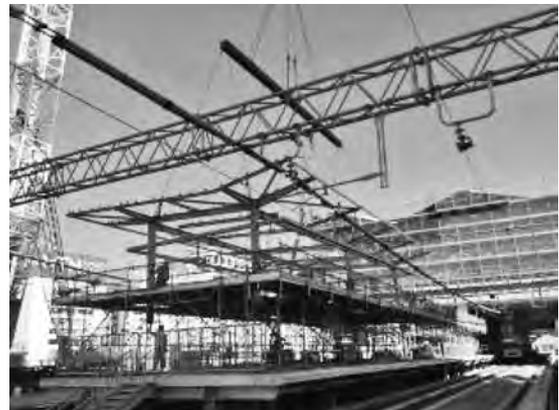
写真一6 ホーム上家鉄骨建方施工状況
