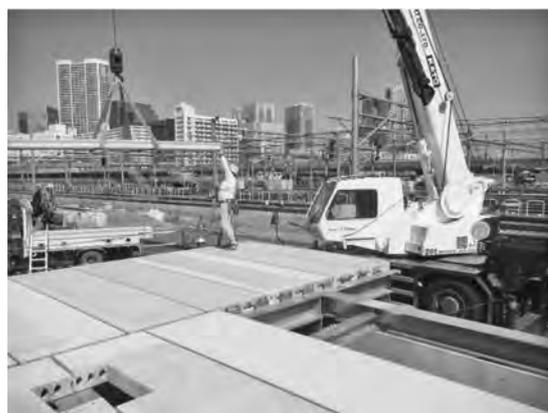
写真-2 ホームPC板施工状況
