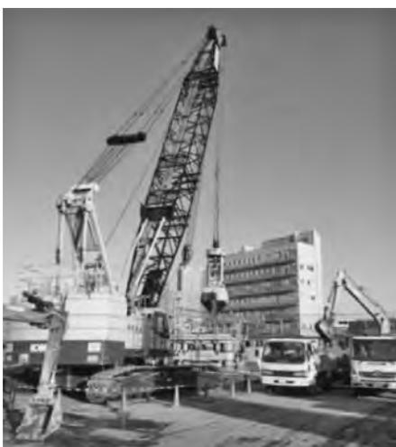
写真－3 杭掘削施工状況
