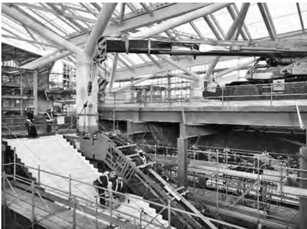
写真一7 エスカレーター吊り込み状況
