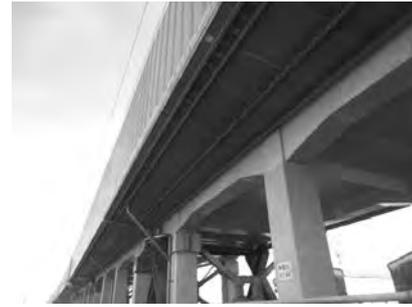
写真一6 はね出し部鋼板被覆の施工例
