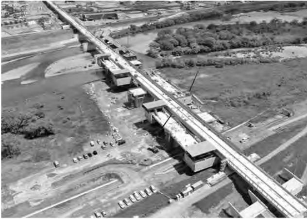
写真一 7 鉄道橋 主桁連結完了
