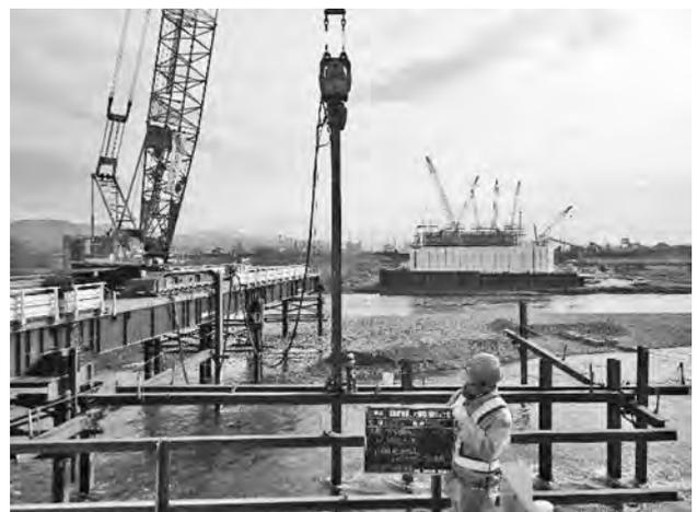
写真-1 仮栈橋施工状況
