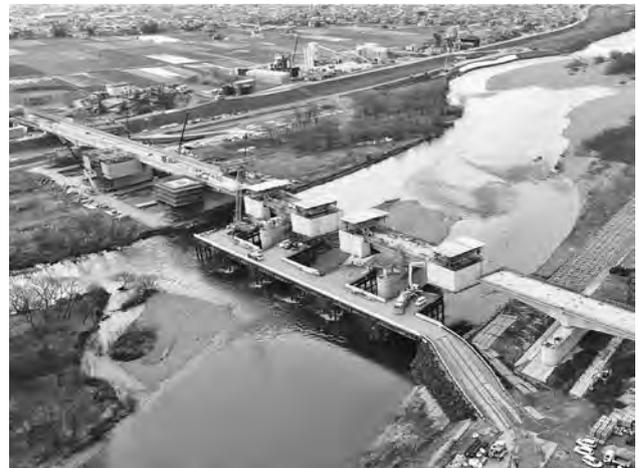
写真—5 張出し施工状況
