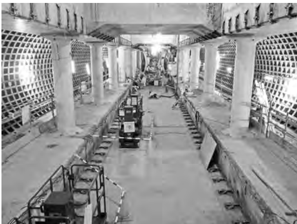
写真一七 切掘り完了写真
