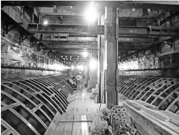
写真一六 シールド接続部切掘り状況
