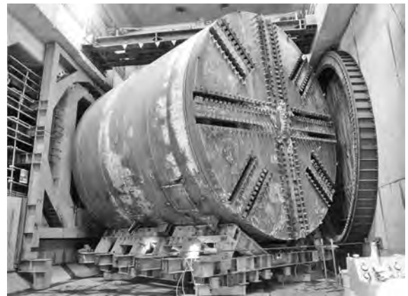
写真一 シールドマシン回転状況
