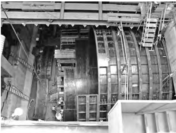
写真一 鋼製隔壁組立状況
