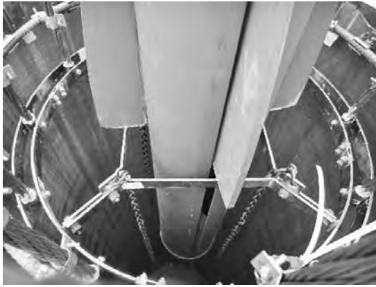
写真一10 杭底フレーム
