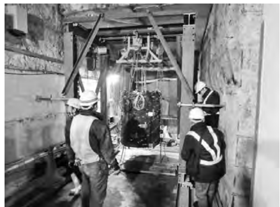
写真—7 建込み架台へのかごの吊り込み
