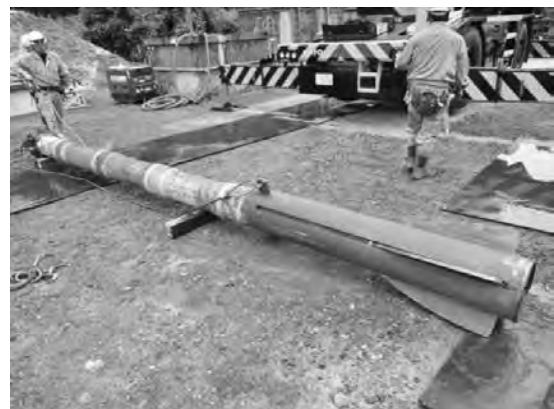
写真—9 接続状態のトレミー管
