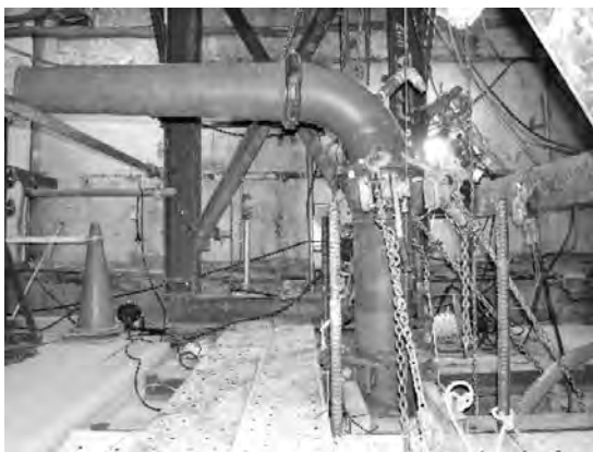
写真一11 場内のポンプ配管からトレミー管への接続
