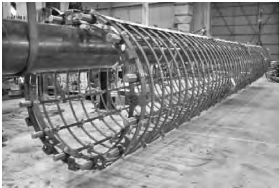
写真—4 鉄筋かごの組立て
