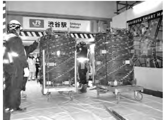
写真—6 鉄筋かごの施工ヤード内運搬
