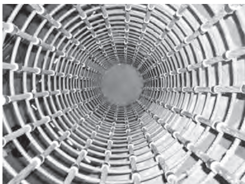
写真一2 伸展した鉄筋かご
