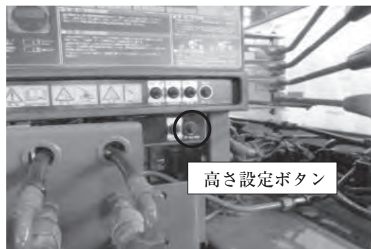
写真—13 自積載クレーン高さ設定
