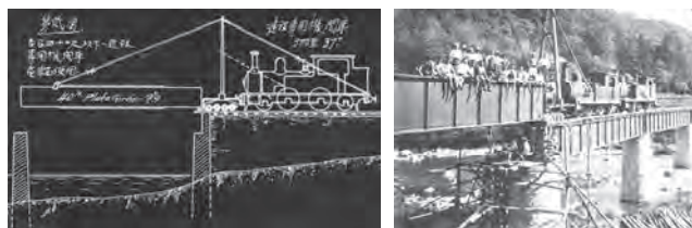
写真-17 SLによる架桁
