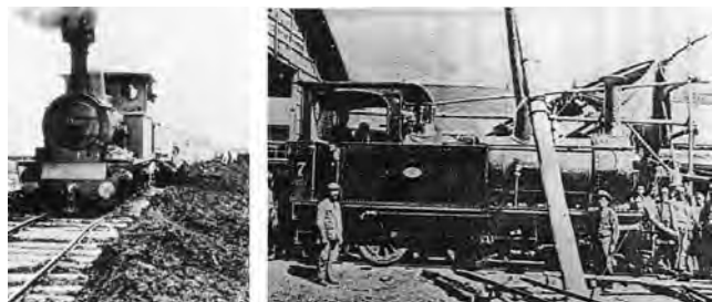
写真-14 荒川千住工場内製20tCタンク 11)
