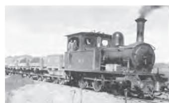
写真一二 石狩川改修 11)
