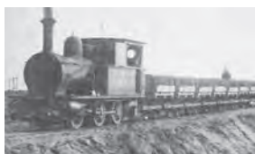
写真-16 雄物川改修 13)
