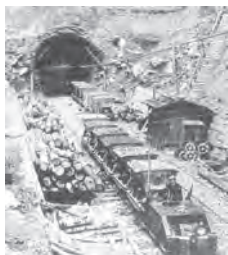
写真一1 笹子隧道坑口
