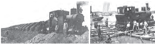
写真一五 利根川改修の排土中と渡河中の Borsig 11)
