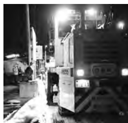
写真—3 掘ギリギリの作業
