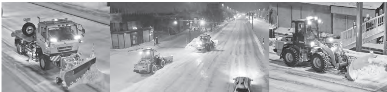
写真一10 国道除雪風景【除雪トラック（トラックグレーダ装置付）、除雪ドーザ】
