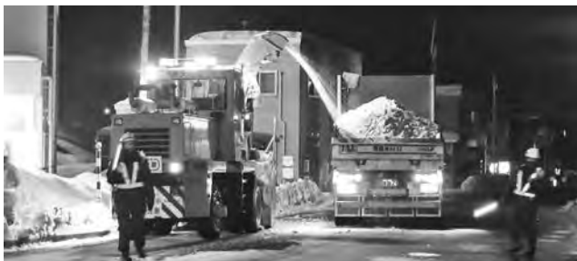
写真—1 排雪運搬作業
