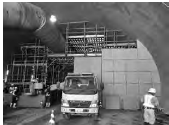
写真一二 紙素材の風門の組立状況
