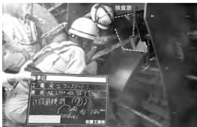
図-1 セントル内での計測
