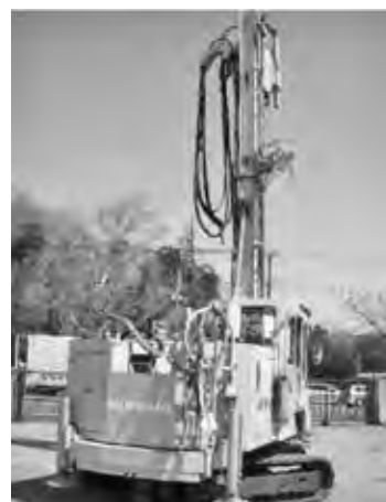
写真—2 小型施工機設置状況
