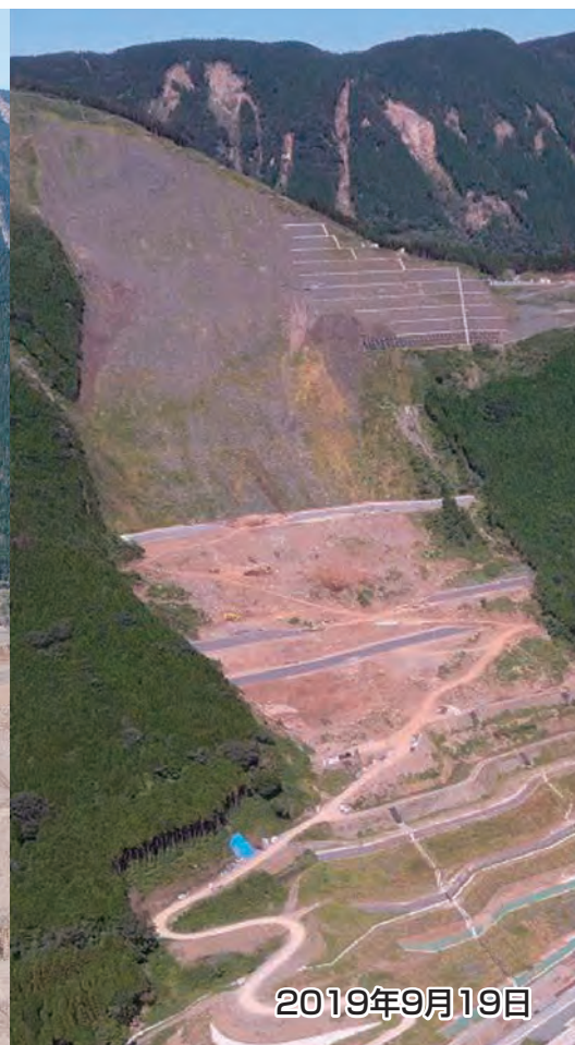
阿蘇大橋地区斜面对策工事 恒久対策工事 緩斜面部土留工施工中
