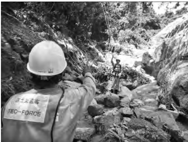
写真—3 地上調査状況
