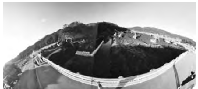
写真—3 北海道胆振東部地震（復旧後）
