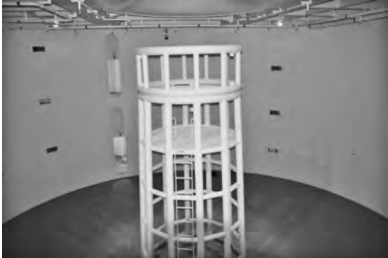
写真一1 ケーブルタンク
