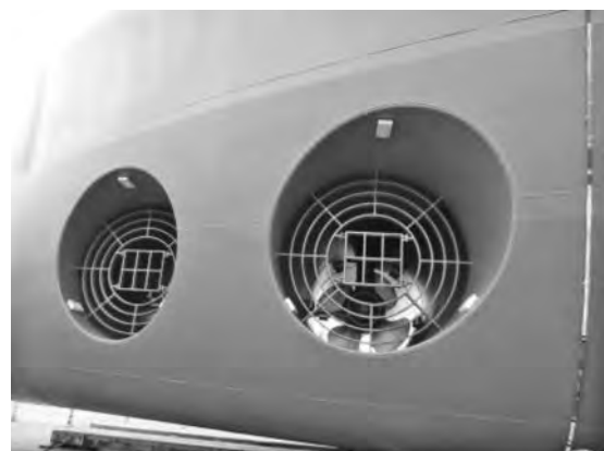
写真—9 トンネルスラスト
