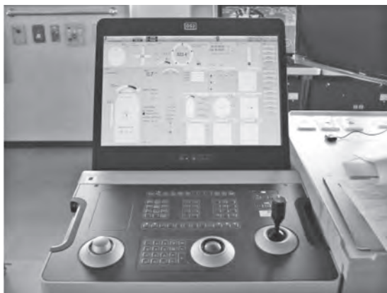
写真—10 DPS 操作盤
