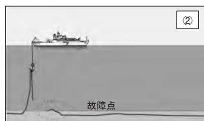
② 探線したケーブル先端を船上に回収
