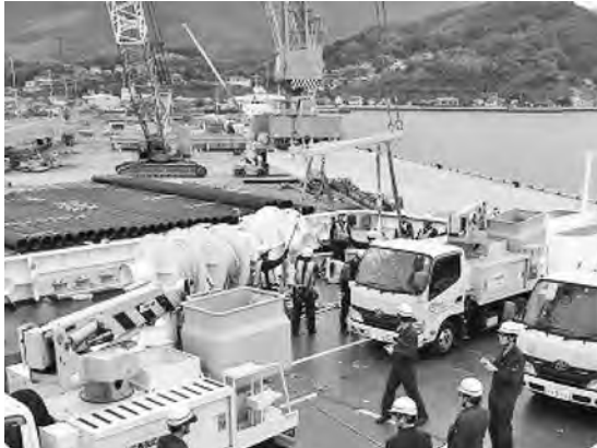
写真—15 作業甲板への車両搭載状況
