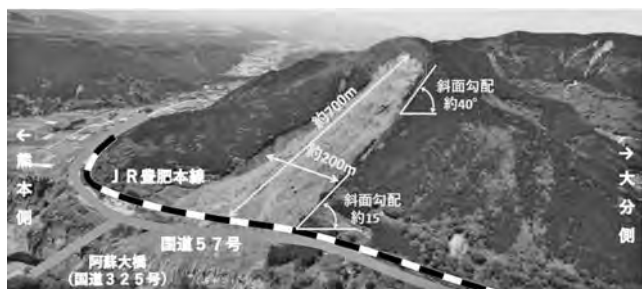
図—1 阿蘇大橋地区の被災状況
