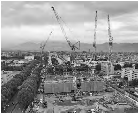
写真一 鉄骨建方状況
