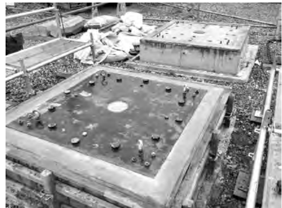
写真-1 免震下部基礎充填試験
