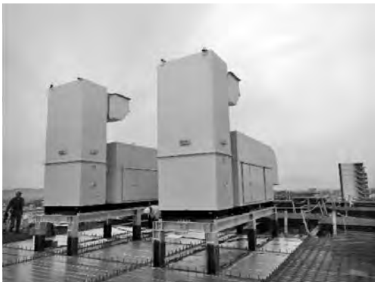
写真三 設備架台
