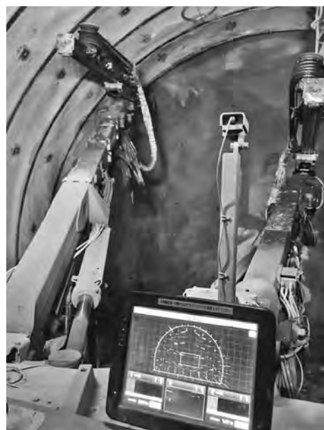
写真—2 発破パターンに準じて削孔している状況
