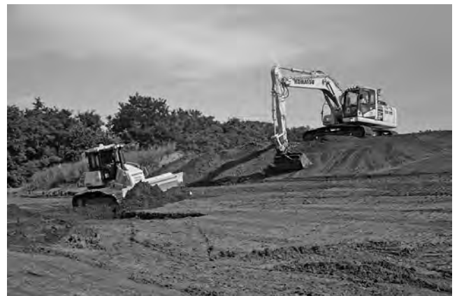
ICT油圧ショベルとICTブルドーザー
