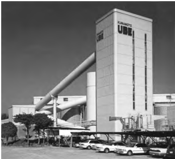
写真一3 コンクリートプラント
