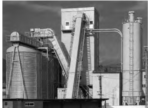
写真一4 骨材輸送装置（急傾斜式）
