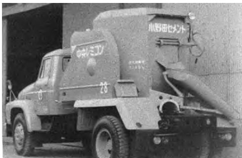
写真一十 ハイロー型トラックミキサ
