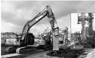
写真一 2 SCM 工法 施工全景 (表層中層混合処理)
