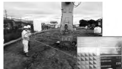
写真一 5 タブレットによる施工管理 (SCM 工法)
