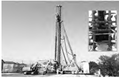
写真一 1 RMP-MST 工法 施工全景 (深層混合処理)
