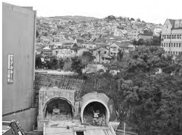
写真一6 オランダ坂トンネル 2)
