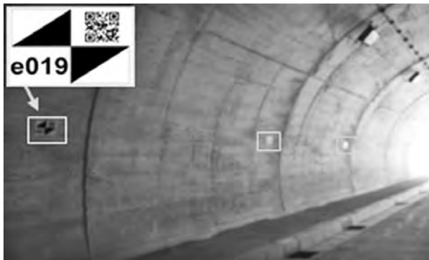
写真—15 トンネルマーカー
