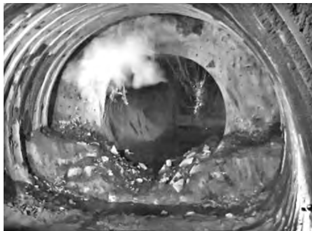
写真一7 安永川トンネル
