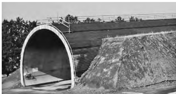
写真-8 実物大模擬トンネル
