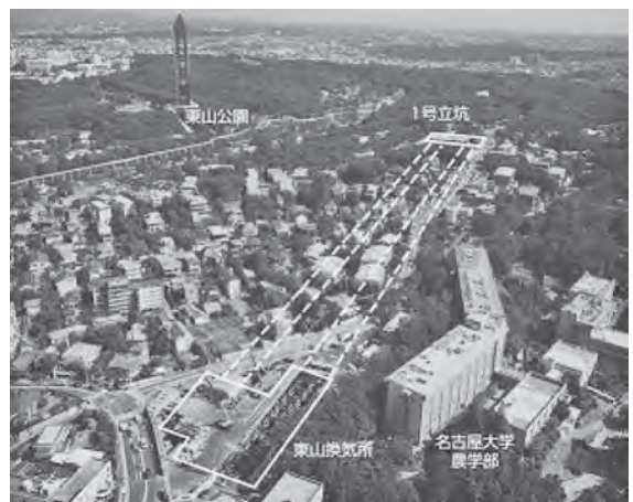
写真三 名古屋高速東山トンネル 1)
