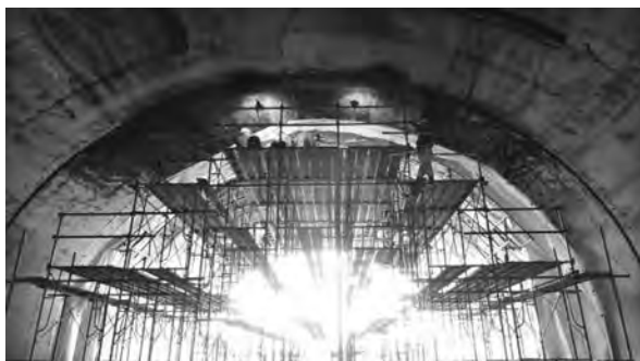
写真—10 防水シートの施工実験
