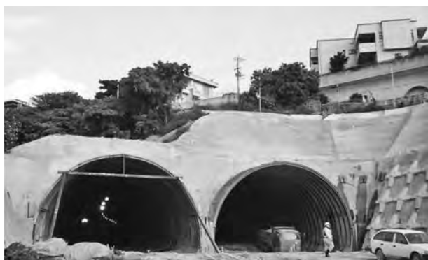
写真一5 識名トンネル
