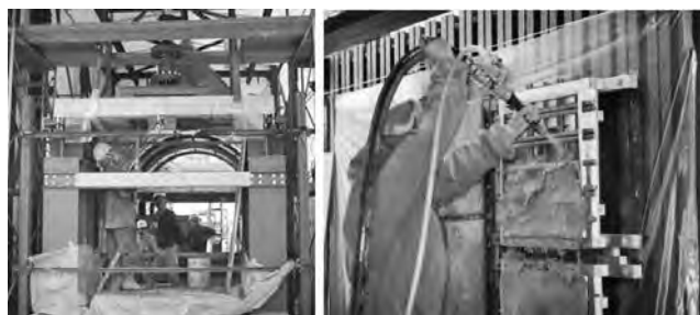
写真—11 吹付け材料の性能評価試験
