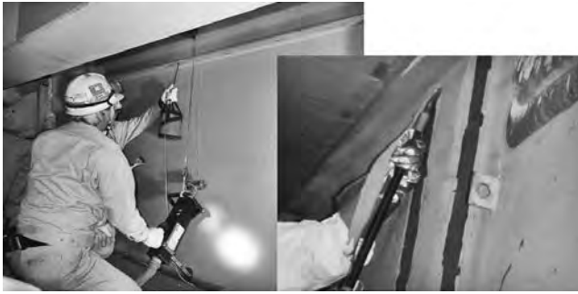
写真一4 電磁誘導加熱 (IH) による塗膜剥離工法
