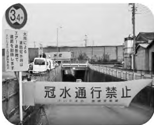
写真-16 エアバルーン式交通遮断機
