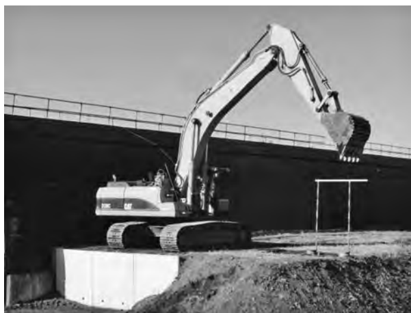
写真一 3 建設機械施工における排出ガスおよび燃料消費に関する調査検討
