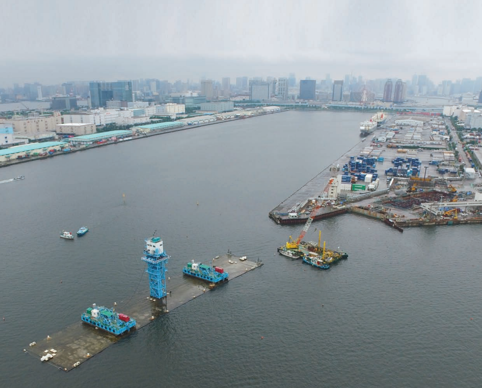
東京港臨港道路南北線沈埋トンネル 最終函（6号函）沈設
