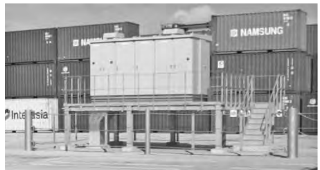
写真—3 電気設備の嵩上げ事例
