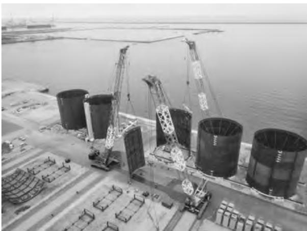
写真一 7 鋼板セル大組立状況
