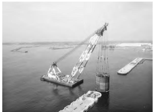
写真一 9 鋼板セル据付状況
