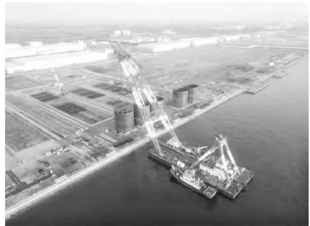
写真一 8 鋼板セル吊込み状況
