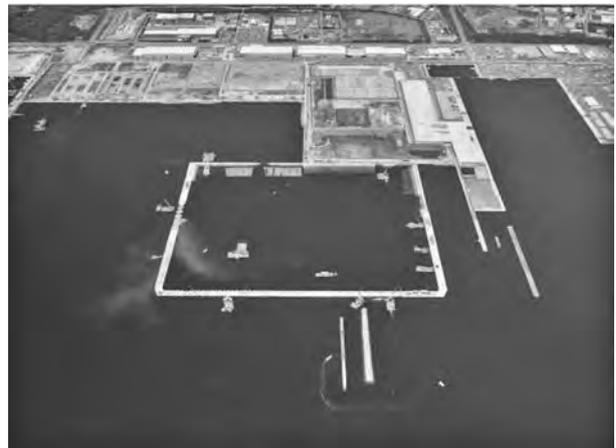
写真—2 鋼板セル護岸施工状況 2019/5
