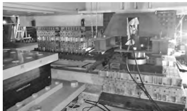
写真一5 降下設備(P1側)
