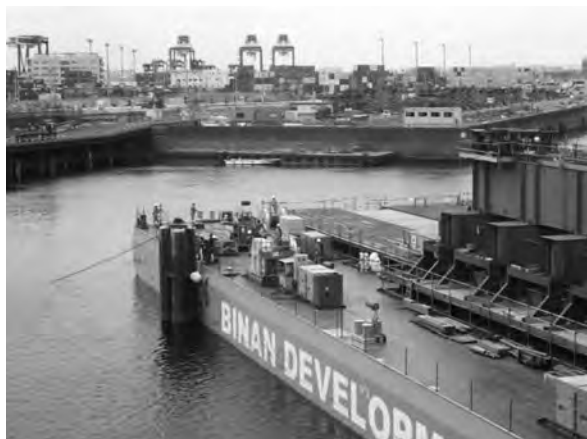
写真一4 係船柱(台船回転中心)
