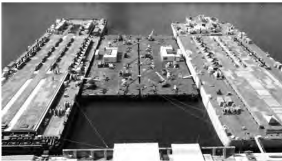
写真一2 台船連結・艤装状況
