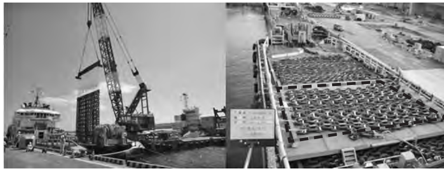
写真一2 500t吊クレーン台船による敷設船への係留チェーン積込状況 (点線枠内はメザニンデッキ部)
