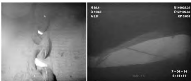
写真一4 係留アンカー・チェーン設置状況 (ROVにより確認)
