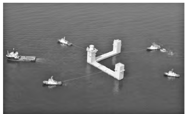
写真一七 7MW 風車用浮体の曳航状況
