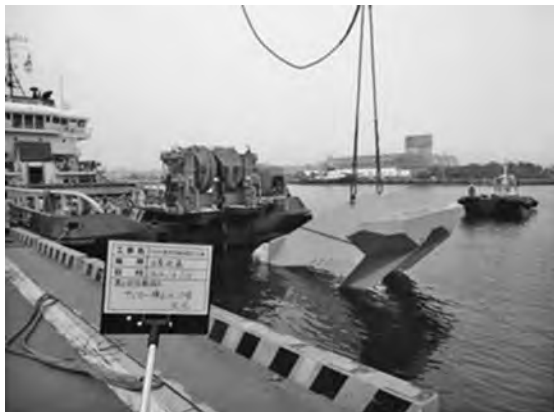
写真一3 係留アンカーの積み込み状況
