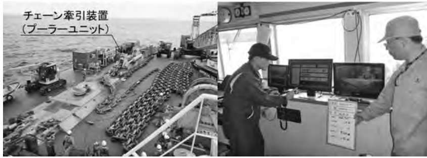
写真一五 引張試験の状況 (荷重 500t × 15分)
