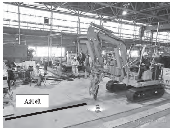
図一9 刃先座標精度試験状況
