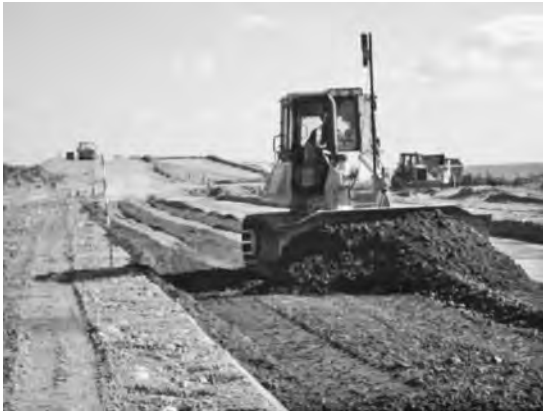
写真一5 7t級ブルドーザ(湿地式)によるCSGの敷き均し
