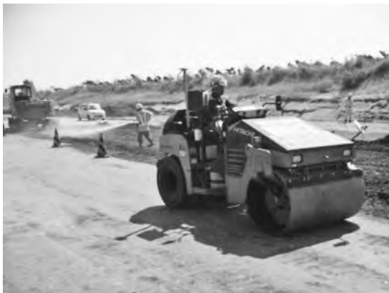
写真一6 4t級振動ローラ(コンバインド型)によるCSGの締固め
