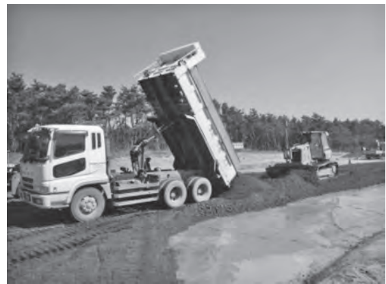
写真-4 10t ダンプトラックによる CSG の荷下ろし
