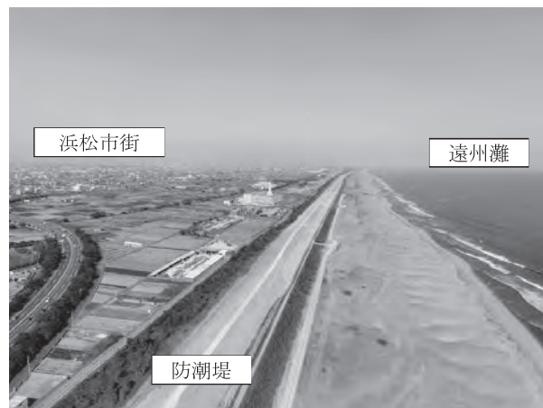
写真-1 完成した防潮堤
