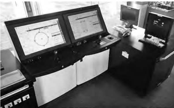
写真—6 自動船位保持装置 操作盤
