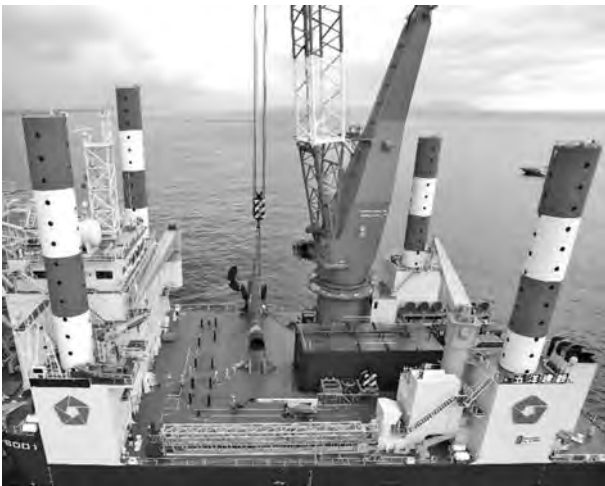
写真—9 杭立て起こし状況
