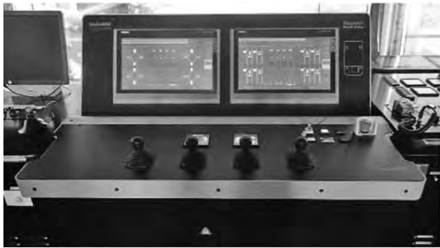
写真-2 ジャッキ装置 操作盤
