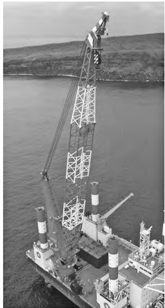
写真-3 800t吊全旋回クレーン
