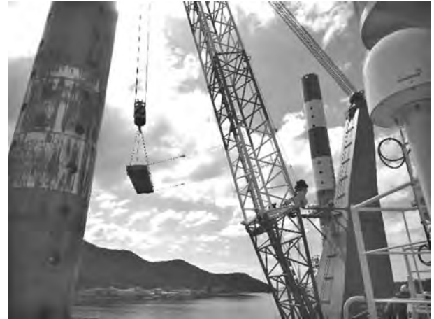
写真—11 タグラインシステム使用状況
