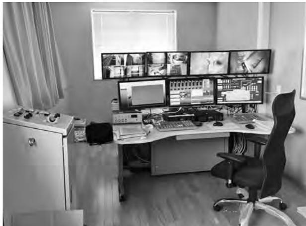
写真一七 計量操作盤
