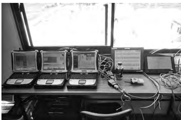
写真-4 自動制御管理室
