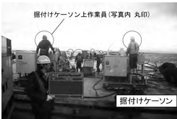
写真-5 従来方法による据付け状況
