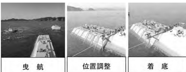
写真-1 ケーソン据付け状況
