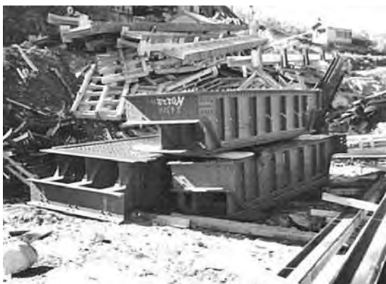
写真—3 高圧スライドゲート扉体仮置き状況
