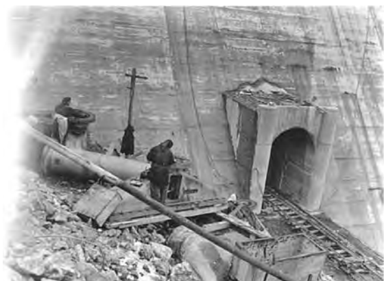
写真—4 高圧スライドゲート搬入状況
