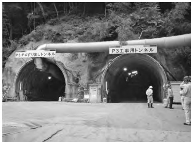
写真—2 工事用トンネル・ずり出しトンネル
