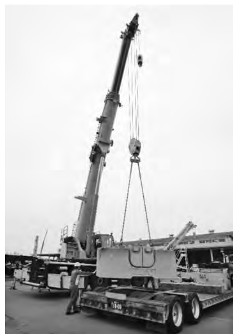
写真-6 カウンターウエイト一体吊り
