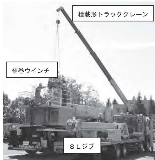
写真一九 SLジブ運搬および補巻ウインチ組立状態
