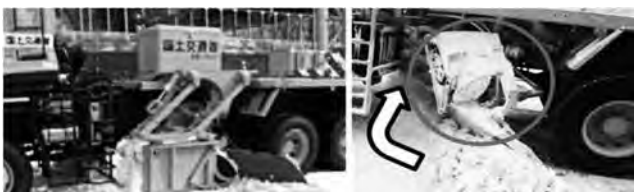
写真-6 サイドシャッタ動作状況
