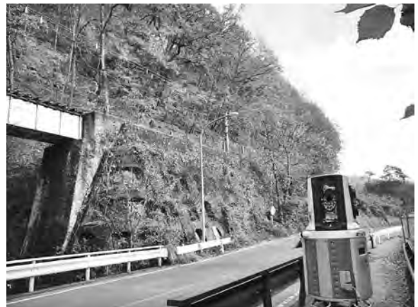
写真—11 3Dレーザースキャナ計測状況
