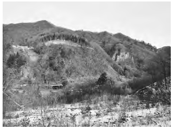
写真—9 堤体左岸法面全景（工事着手時）
