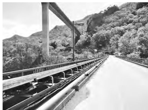
写真一 3 ベルトコンベア設置状況 (TBC11 ~ 12)
