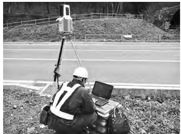
写真-1 3Dレーザースキャナ使用状況
