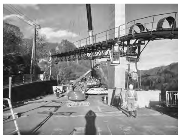
写真一 5 工事用道路部組立状況 (TBC13)
