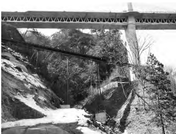
写真一 2 ベルトコンベア設置状況 (TBC10)
