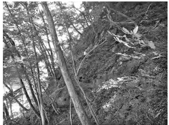
写真—10 堤体左岸法面状況
