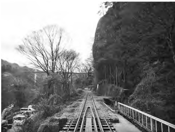
写真一七 岩壁張り出し部の状況
