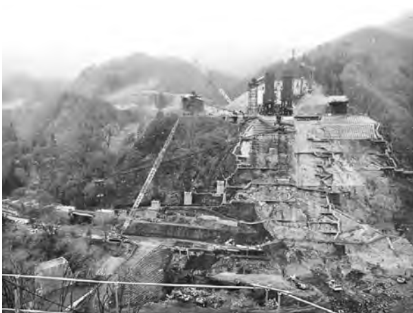
写真—15 旧国道からのSBC6組立状況
