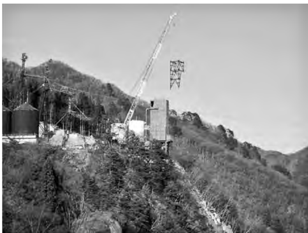
写真—14 左岸天端からのSBC6組立状況
