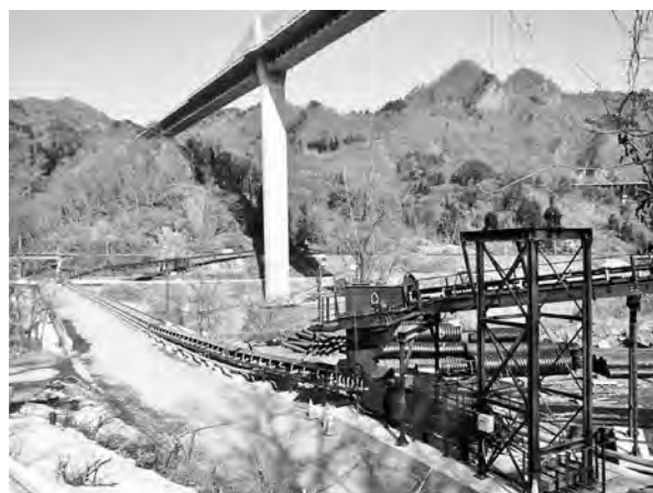
写真一 4 ベルトコンベア設置状況 (TBC12 ~ 13)
