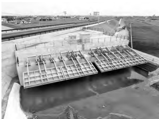
写真—2 設置状況 2 (津波対策用ゲート)
