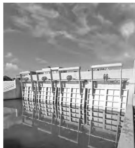
写真-1 設置状況 1 (津波対策用ゲート)
