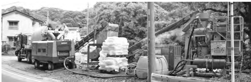
写真-3 狭隘地での吹付システムプラント設置例
