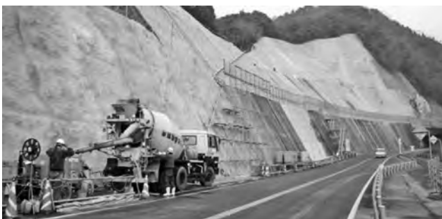
写真—4 ポンプ圧送エア併用吹付システムプラント設置例
